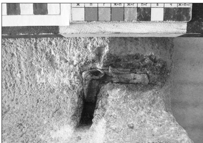
Рис. 9. Закрепление остатков корродированного металла в пазах карнизных плит. Керчь, декабрь, 2015 г. Съёмка Н. Л. Кучеревской. Архив отдела «Лапидарий».
