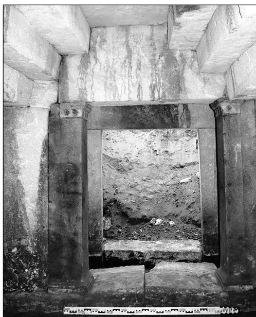
*Рис. 2. Оформление входа из дромоса в склеп двумя пилястрами с рельефными базами и монолитными дорическими капителями с росписью. Ленинский р-н, декабрь, 2008 г.*
